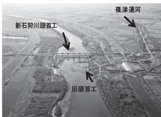
新・旧頭首工を上流側から望む
