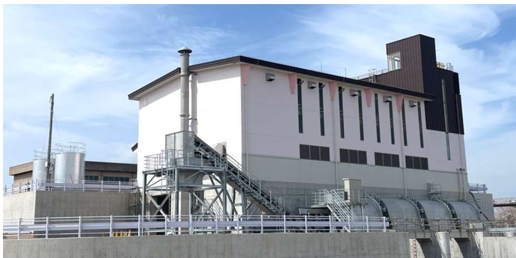
与良川統合排水機場 写真提供 関東農政局栃木南部農業水利事業
